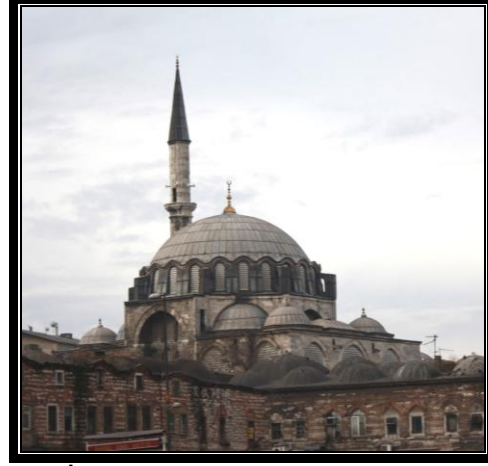
İstanbul Rüstem Paşa Camii
